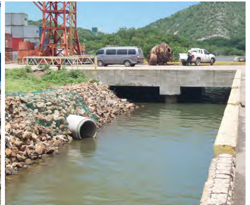
■ Drenaje detrás de muelle seis
