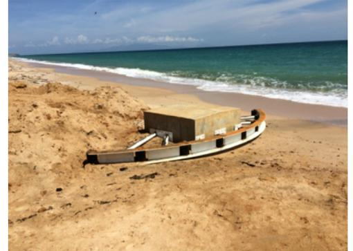
Corredera semicircular y bloque de anclaje construidos para facilitar el halado del cable sin riesgo de dañarlo
