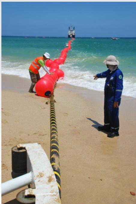
Halado y posicionamiento final del cable desde el barco hasta la costa
