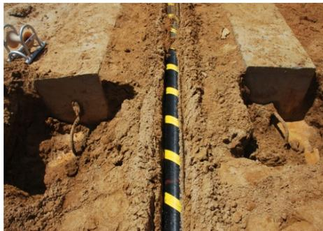
Cable en pieza de sujeción en tierra durante la fase de halado
